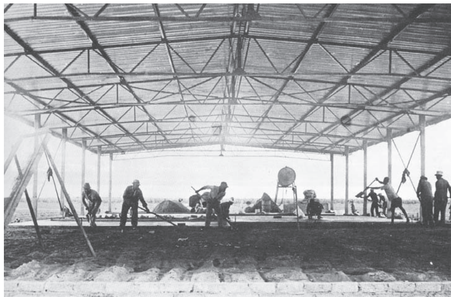
Die eerste geboue het in 1974 op die permanente Oesdagterrein verrys. Hier word die vloer van een van die restaurante gegooi.
